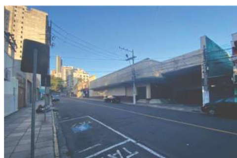
Vista da fachada da área de intervenção para a Rua Gomes Portinho
