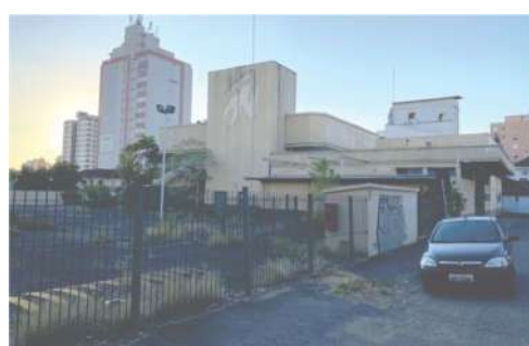
Vista geral da área de intervenção para a Rua Caju
